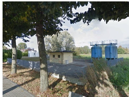
Area pertinenza pozzi
