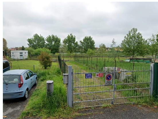
Cabina gas metano
