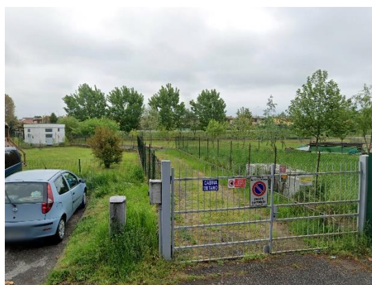
Cabina gas metano
